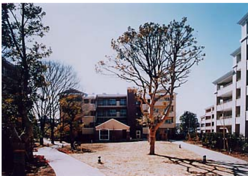
◆レイクフィールド（A工区）の完成写真②（中央・B棟、右・E棟）
