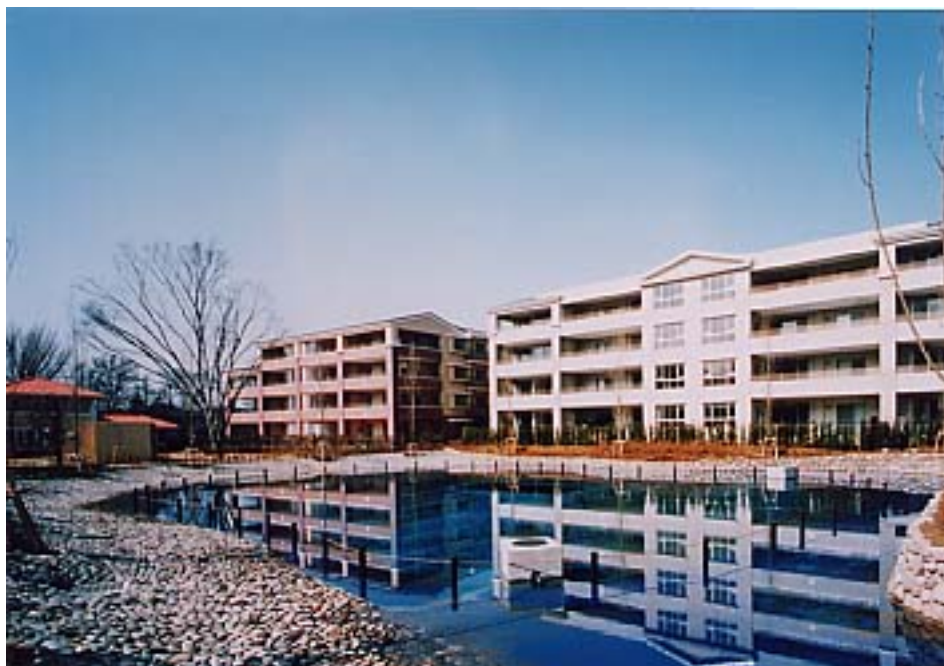
◆レイクフィールド（A工区）の完成写真①（左・F棟、右・G棟）
