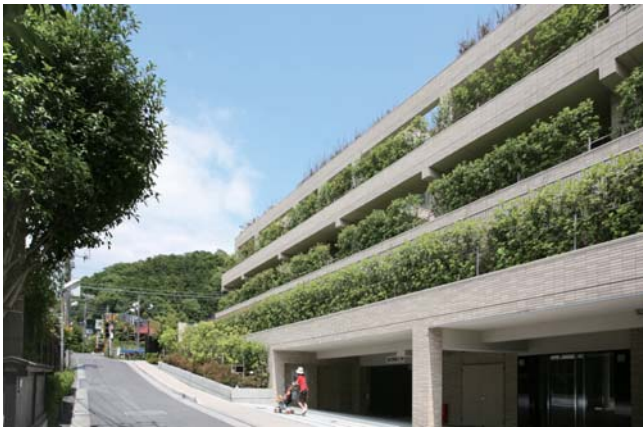
階段状にセットバックしたバルコニー
