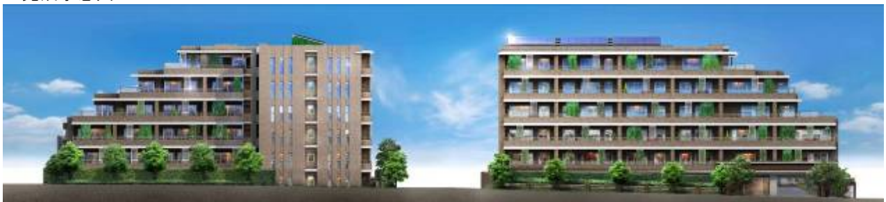
南西側（左）および南東側（右）外観
