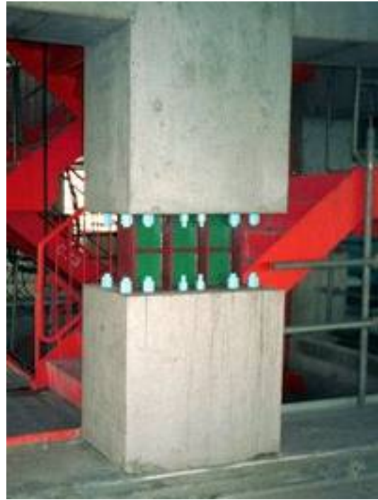
制震柱施工事例
