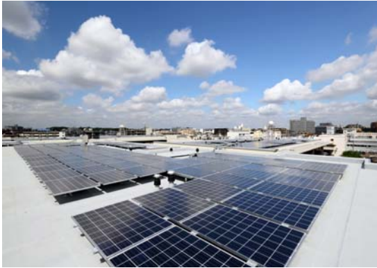
太陽光発電システム
