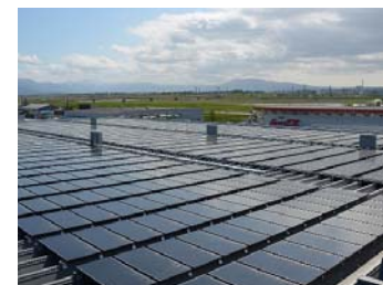
北陸コカ・コーラボトリング(株) 砺波工場「太陽光発電設備」
