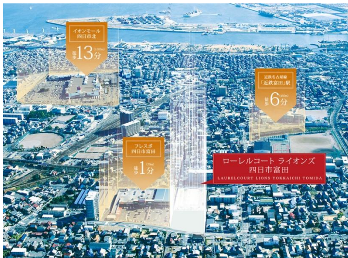
「ローレルコート ライオンズ四日市富田」建設地周辺の空撮写真
