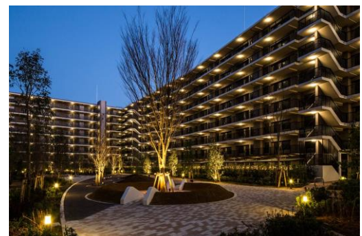
建物外観写真
