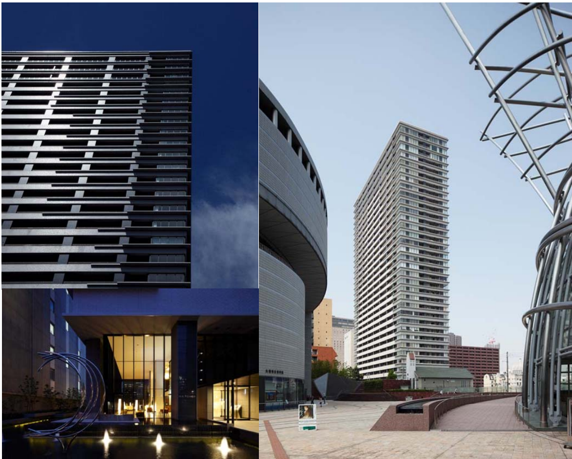
左上：南面見上げ、左下：街と調和した開放的なランドスケープを構築する水盤とオブジェ 右：国立国際美術館からの見上げ
