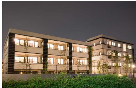
隣地公園からの外観
