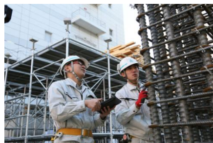
施工現場でタブレットを活用する社員
