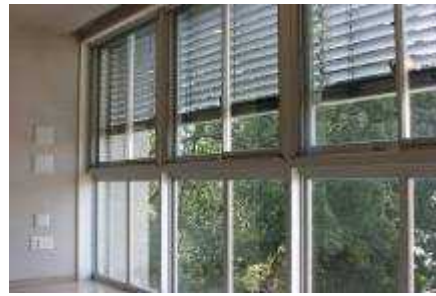
住戸内から撮影
