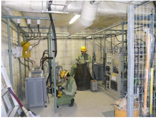
工事前の検査
