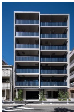
ライオンズフォーシア押上 (2021年8月竣工)
