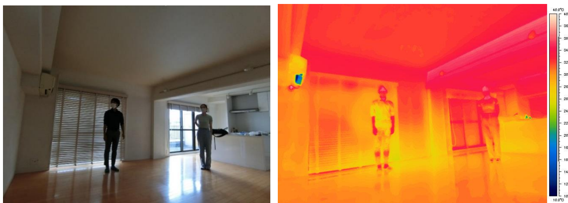
断熱性能・日射遮蔽性能の不足により、住戸内の温度環境が均一でない様子
