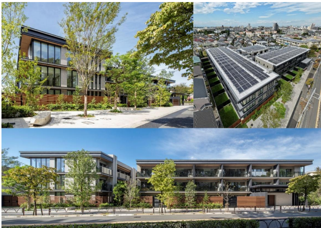
「ザ・ライオンズ世田谷八幡山」外観および屋上の太陽光発電設備
